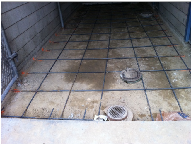
3. Landing pour backs in progress.
